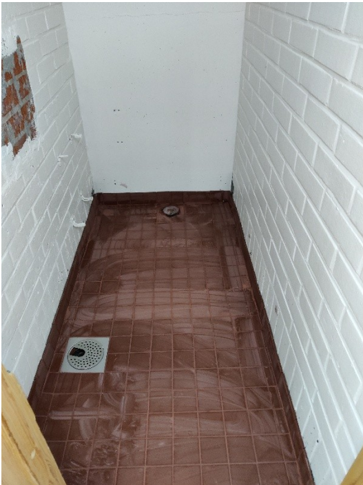
Kuva 3. C-solulla saumataan märkätalalaatoituksia sekä levitetään viimeisiä vedeneristeitä.
