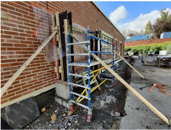
Kuva 2. D-solulla kaasukeskukselle on valettu uusi antura, sokkeli ja seinät.
