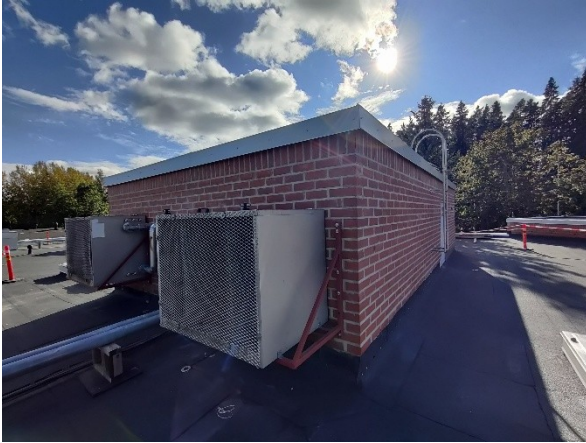
Kuva 1. D-solun katolla sijaitsevan konehuoneen muuraus on valmistunut ja sääsuoja on purettu.
