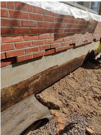
Kuva 3. D-solulla sokkelin vedeneristys käynnissä.
