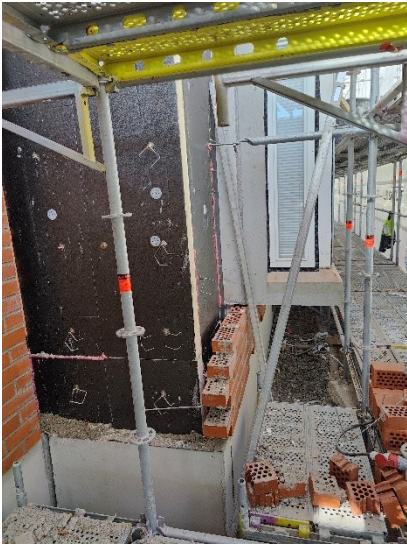
Kuva 1. C-solulla uuden Julkisivumuurauksen ja -eristeen työt etenevät.
