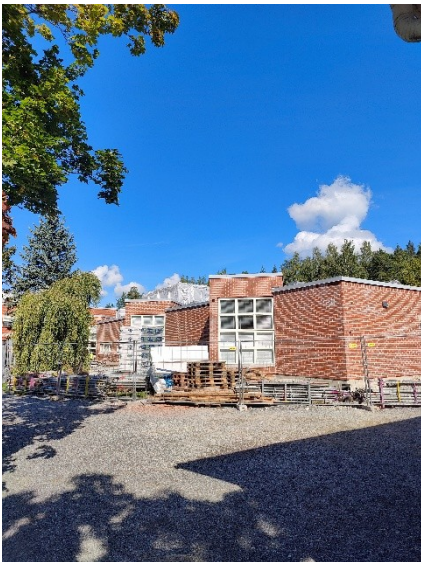
Kuva 2. D-solulla lopun telineen purku viimeistelyssä.
