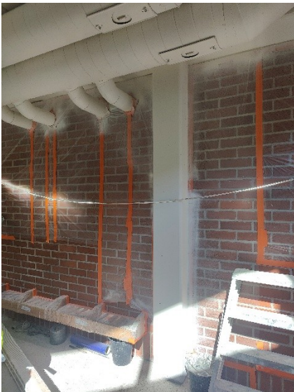
Kuva 2. C-solulla maalaustyöt etenevät.
