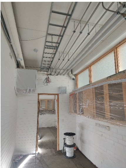
Kuva 3. C-solulla sähkötyöt aloitettu.
