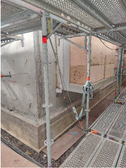
Kuva 1. B-solulla Julkisivumuurauksen ja -eristeen purku valmistunut.
