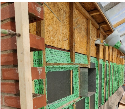
Kuva 3. D-solulla IV-konehuoneen muuraus.
