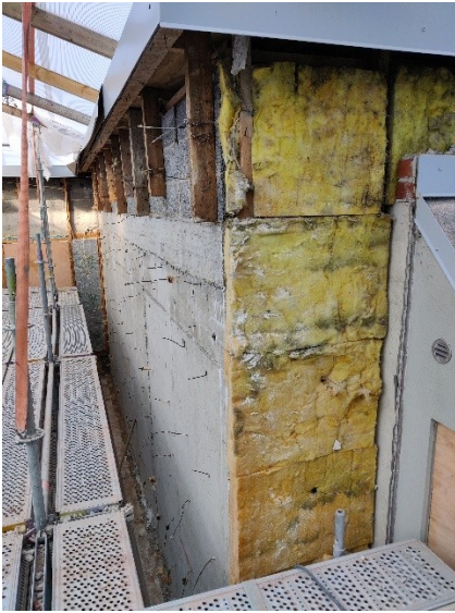
Kuva 1. B-solulla purkuteline valmistunut. Julkisivumuurausten ja -eristeen purku jatkuu.
