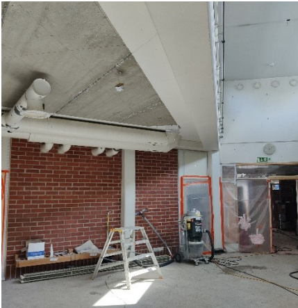
Kuva 2. C-solulla sisäpurku on valmistunut.
