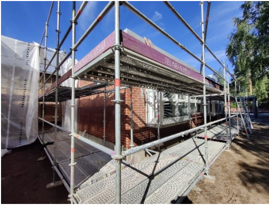
Kuva 1. B-solulla asennetaan purkutelinettä. Julkisivunpurkua on tarkoitus jatkaa kuluvalle viikolla.
