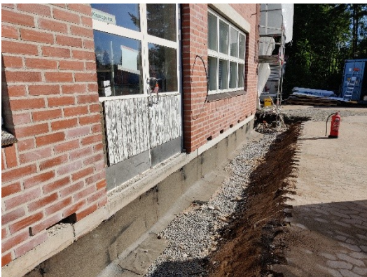
Kuva 3. D-solulla sisäänkäynnin teline purettu. Sokkeli vedeneristetään bitumilla ennen maatayttöä.
