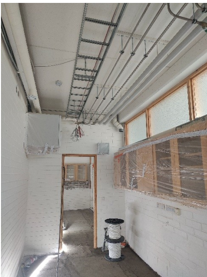
Kuva 3. C-solulla sähkötyöt aloitettu.
