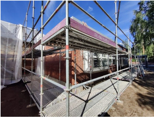
Kuva 1. B-solulla asennetaan purkutelinettä. Julkisivunpurkua on tarkoitus jatkaa kuluvalla viikolla.
