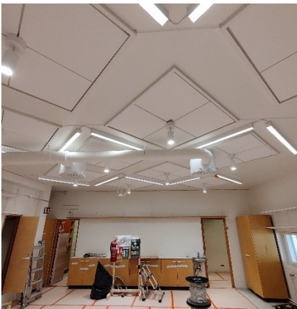
Kuva 2. D-solulla suoritetaan viimeisiä asennuksia ja loppusiivouksia, ennen lattiasuojien poistoa.
