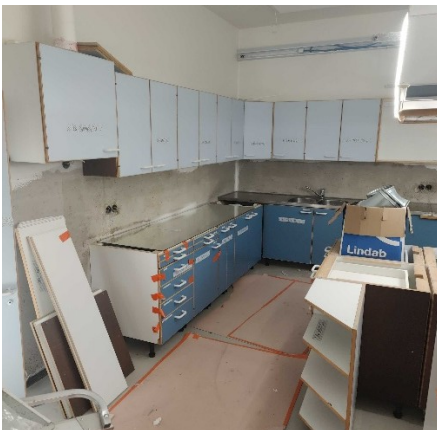
Kuva 2. D-solun opetuskeittiön kalusteiden takaisin asennus käynnissä ja välitilalaatoitus alkamassa
