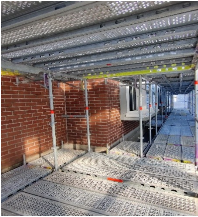
Kuva 1. C-osion julkisivun purku- ja muurausteline
