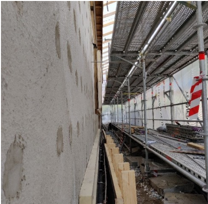
Kuva 2. Uusittavan sokkelin raudoitus ja motitus.
