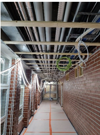
Kuva 3. Käytävän alakattorunko ja sähköjen uusiminen
