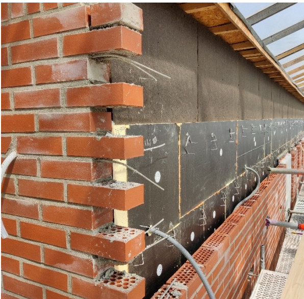
Kuva 2. Uusi julkisivumuuraus
