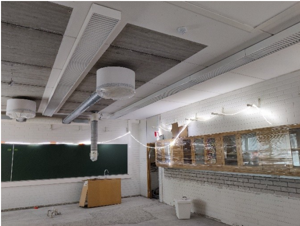
Kuva 1. C-Solun purkutyöt käynnissä
