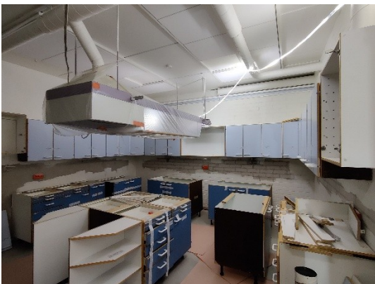
Kuva 3. Opetuskeittiössä kalusteasennukset etenevät kovalla vauhdilla
