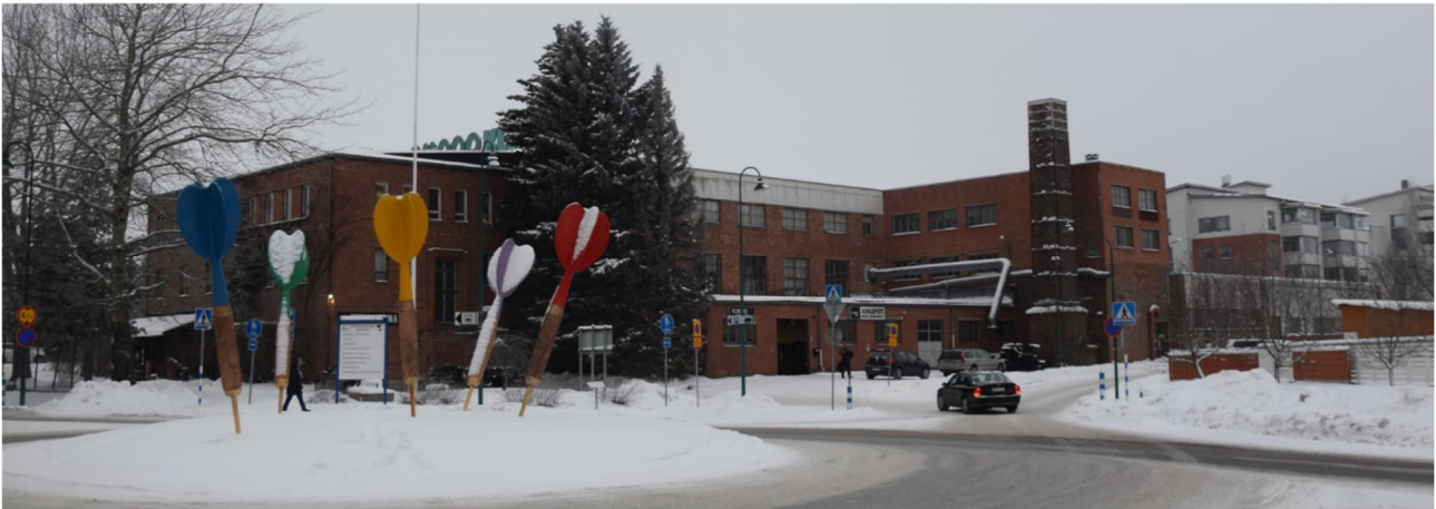
Kuva 4 Piippokeskus kaakkoiskulmasta kuvattuna. Tehtaan alkuperäinen savupiippu on rakennuksen katujulkisivun huomiota herättävin elementti. Etualalla Pekka Jylhän taideteos, joka viittaa tehtaan valmistamiin tikkataulutuotteisiin.
