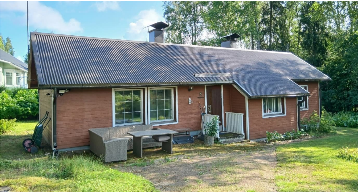
Kuva: Aarnenpolku 5 asuinrakennus. Kuistin vasemmalla puolla on 1970-luvulla rakennettu laajennusosa.
