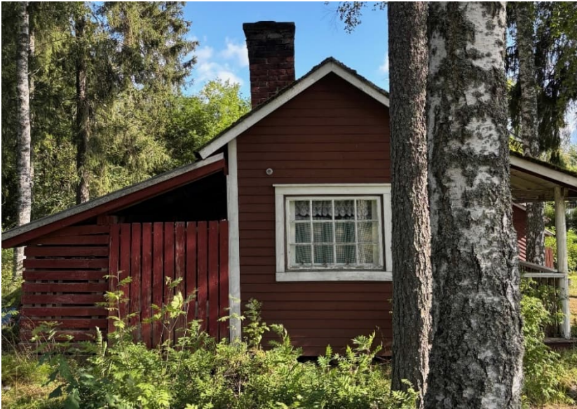
Kuva: Aarnenpolku 5 saunarakennus.
