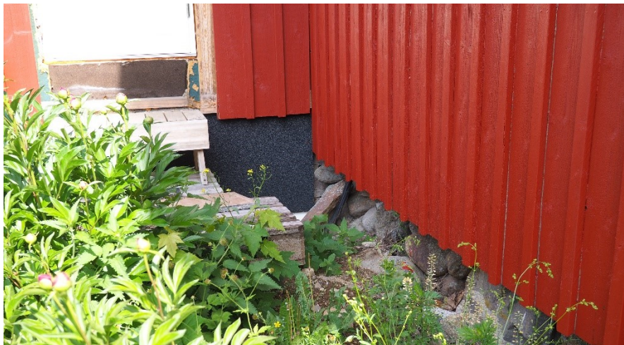
Kuva 15 Vanhan osan luonnonkiville perustettu rossipohja ja kylpyhuone-laajennuksen betonisokkeli.
