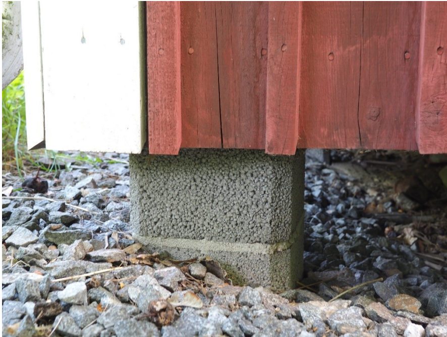
Kuva 18 Pihan puolella rakennuksen perustuksia on uusittu pilariharkoilla.
