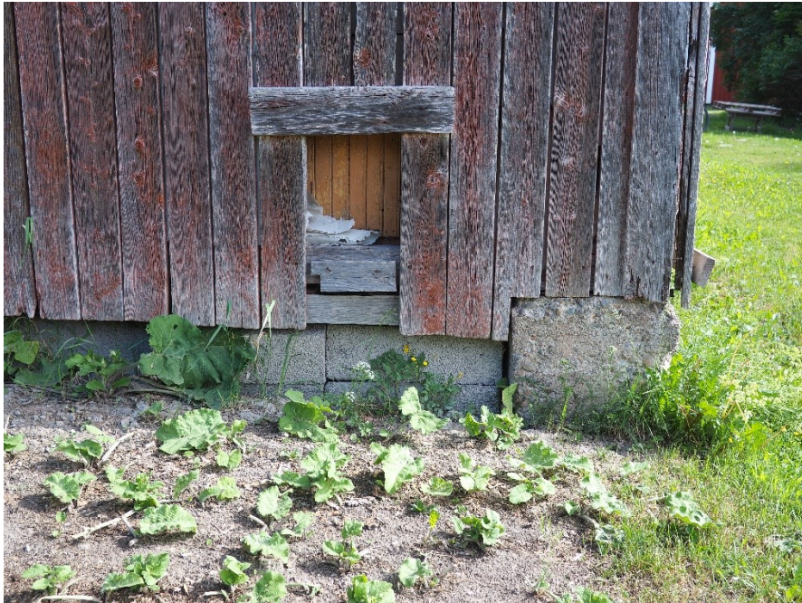
Kuva 21 Navetan pohjoispääty on perustettu betonille ja soraharkolle.
