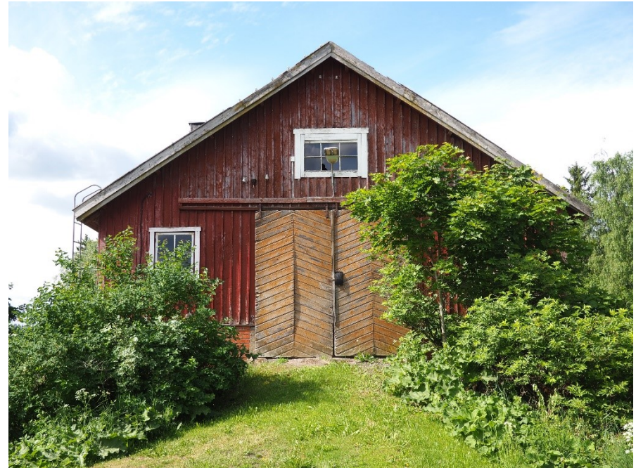
Kuva 22 Navetan koillispäädyssä on kookkaat vinolautaovet.
