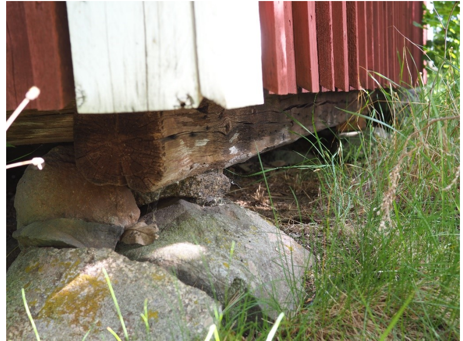
Kuva 19 Rakennuksen etelänurkat on perustettu luonnonkivelle.
