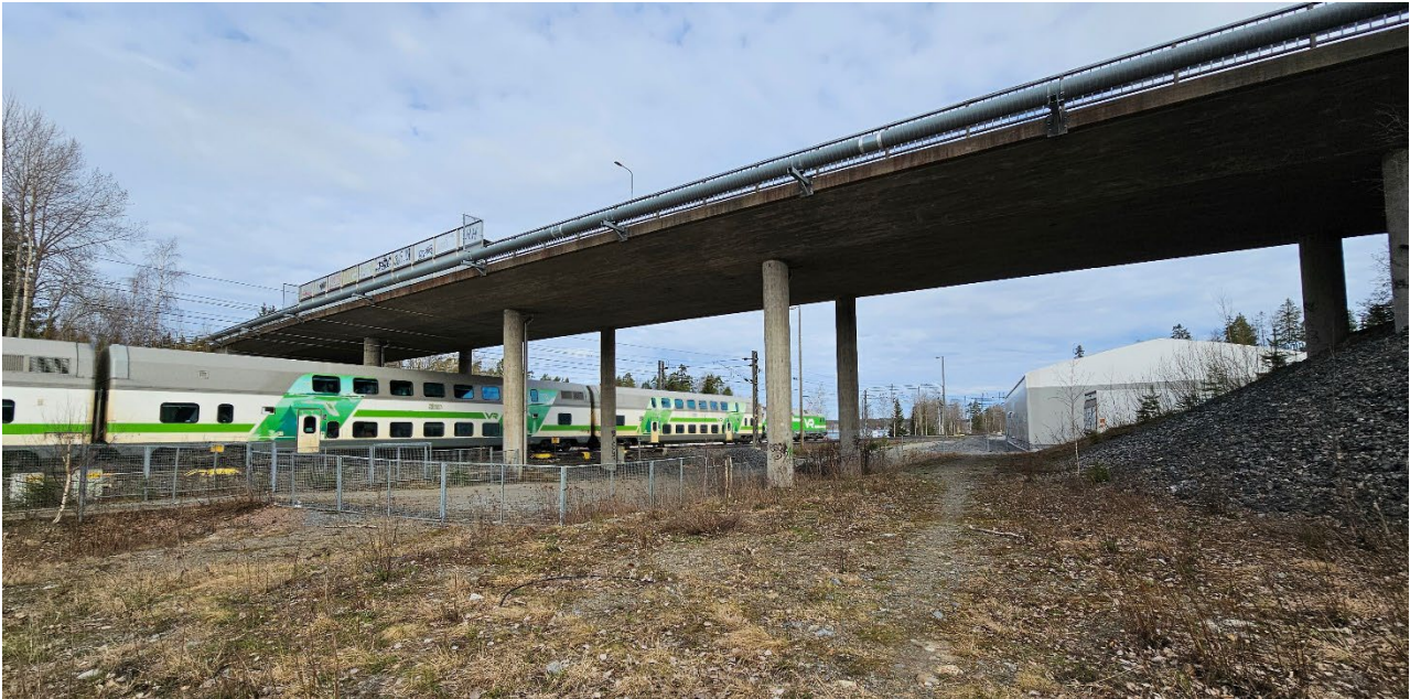
Kuva 1 Sääksjärven ylikulkusilta Sääksjärventien kohdalla, kuva 5.3.2024.
