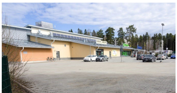
Kuva 6 S-market, Tampereentie 453, kuva 5.3.2024.
