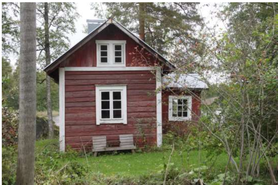
Kuva 122. Hirsirakenteinen pieni pirtti. 3278
