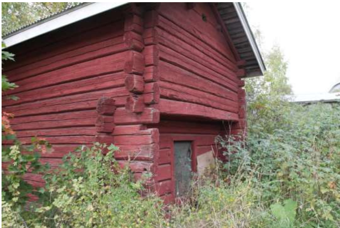
Kuva 139. Hirsirakenteinen aitta on siirretty paikalle. 3466
