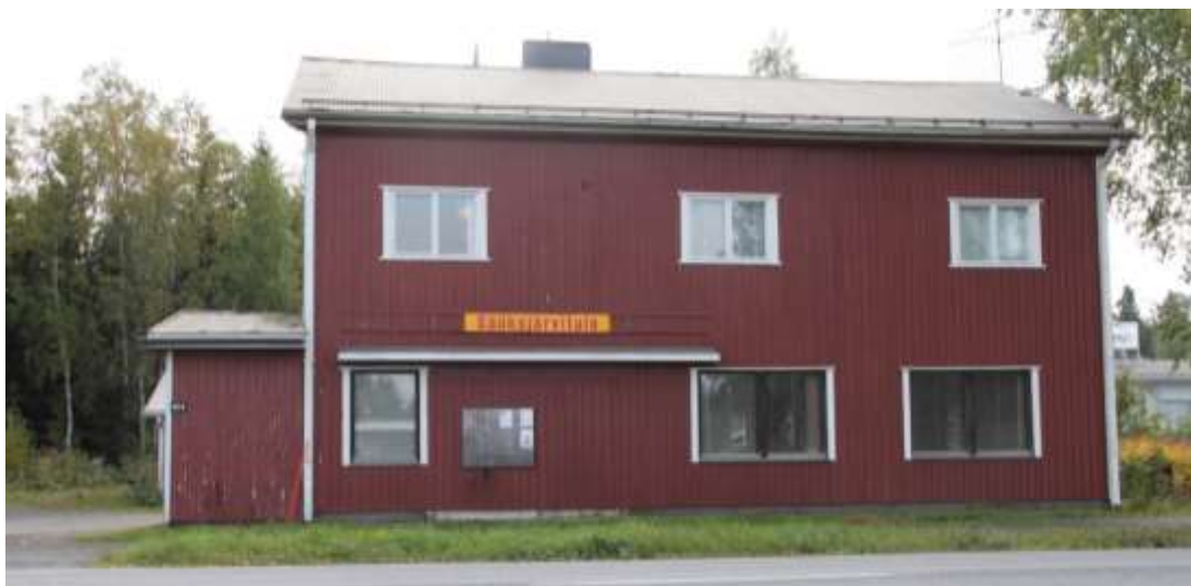
Kuva 18. Sääksjärvitalon Tampereentien puoleinen julkisivu. Ikkunat on uusittu. Kaupan entisen sisäänkäynnin yllä ollut ajalle tyypillinen lippa on säilynyt julkisivussa, vaikka sisäänkäynti on rakennettu umpeen. 2770
