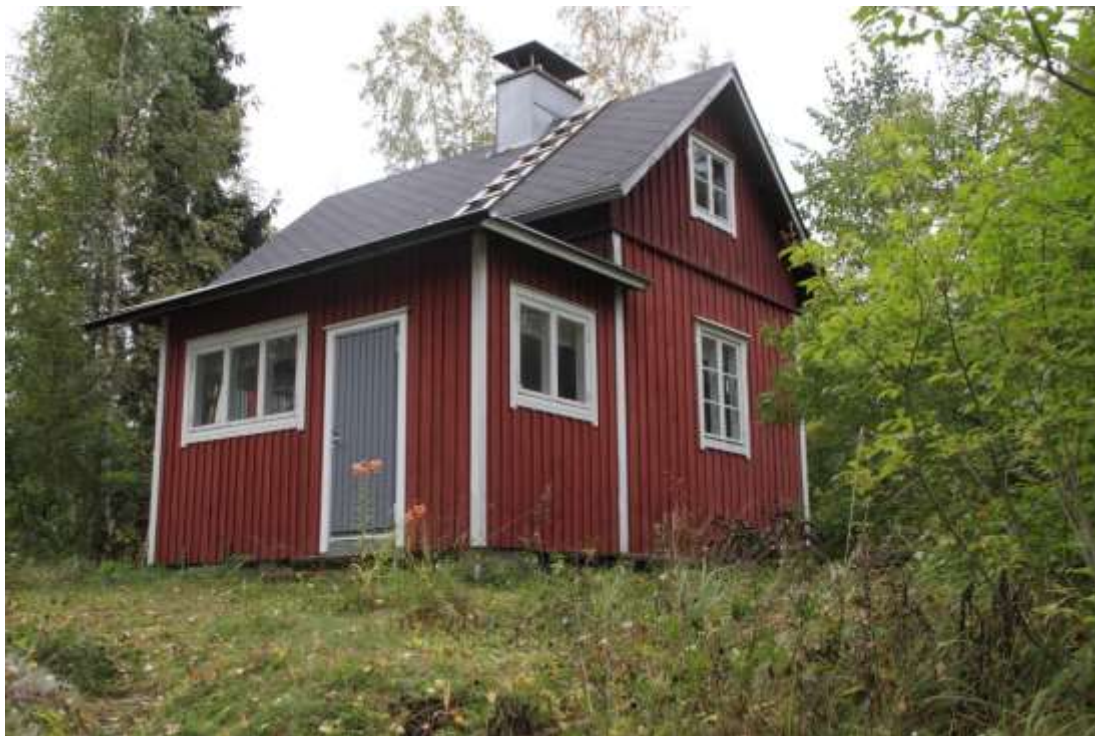
Kuva 123. Kohteen päärakennus on tontin korkeimmalla kohdalla. 3284
