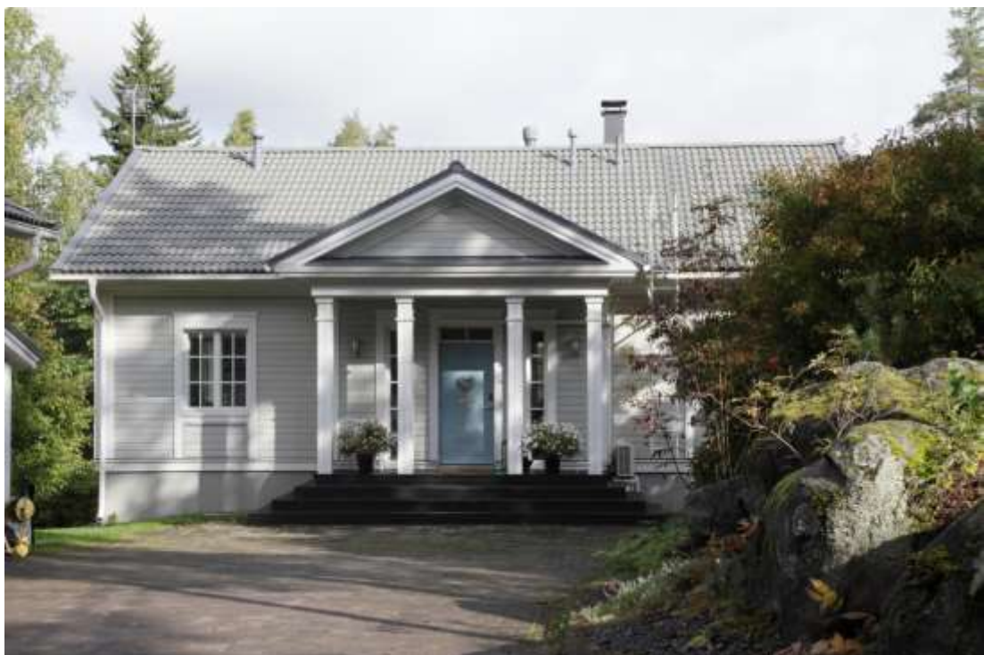
Kuva 27. Sipiläntie 20 on huvilarakentamista jäljittelevä asuinrakennus 2000-luvulta. 2844
