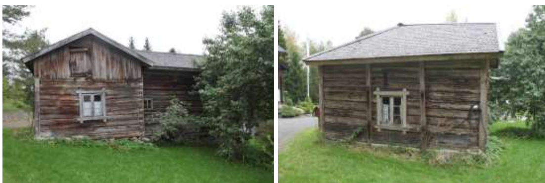
Kuva 127. Oikealla torpan eteläjulkisivu, vasemmalla länsijulkisivu. 3317, 3324
