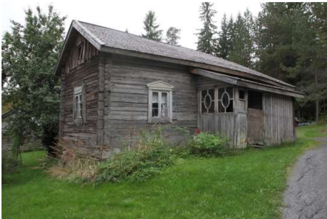
Kuva 126. Entisen torpan päärakennus, pohjoisjulkisivu. 3309
